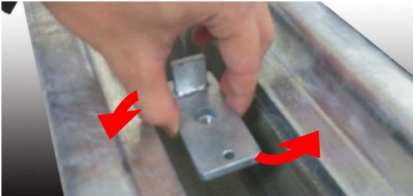
④ ボルト穴位置に固定金具位置を合わせる▼
