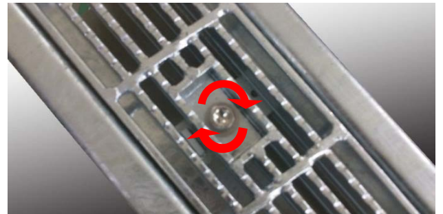
⑤ 六角レンチでボルトを締付ける▼
