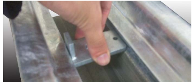
⑤ 六角レンチでボルトを締付ける▼
