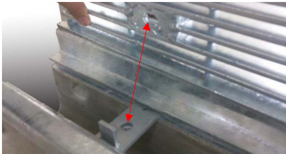
④ ボルト穴位置に固定金具位置を合わせる▼
